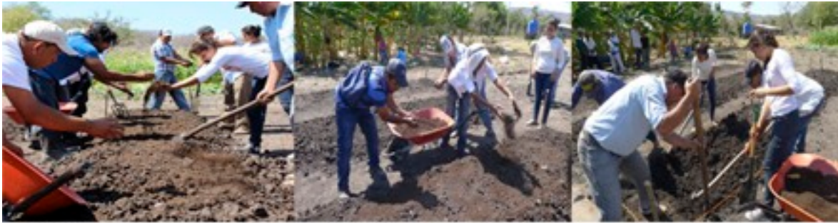
Nivelan con tierra el banco de la doble excavación
